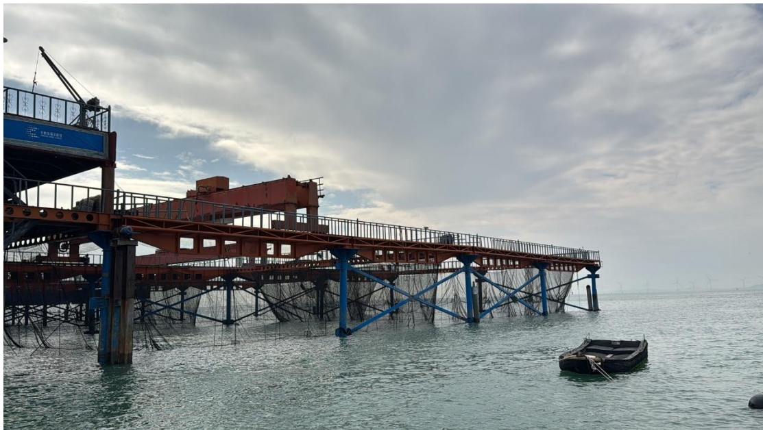
图 1.5-2 桩柱式桁架养殖平台实景图
