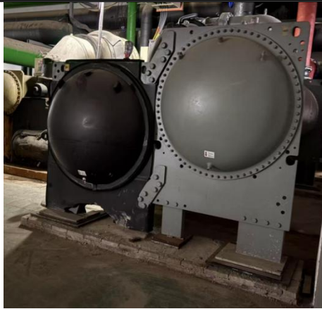
现有工程设备底座减振
