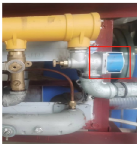
熄火保护装置电磁阀
