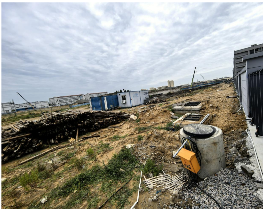
北侧道路现状（网龙二路）
